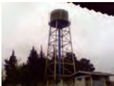
عضو کششی به عنوان مهاربند قطری نمونه‌هایی از اعضای کششی در سازه‌های مفتلف
