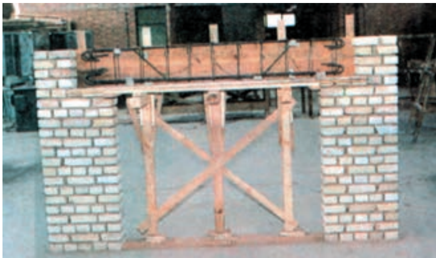
شکل ۱۳-۳- نمایش مجموعه‌ی میل‌گرد و فاصله نگه‌دارهای مربوط در قالب پوتر
