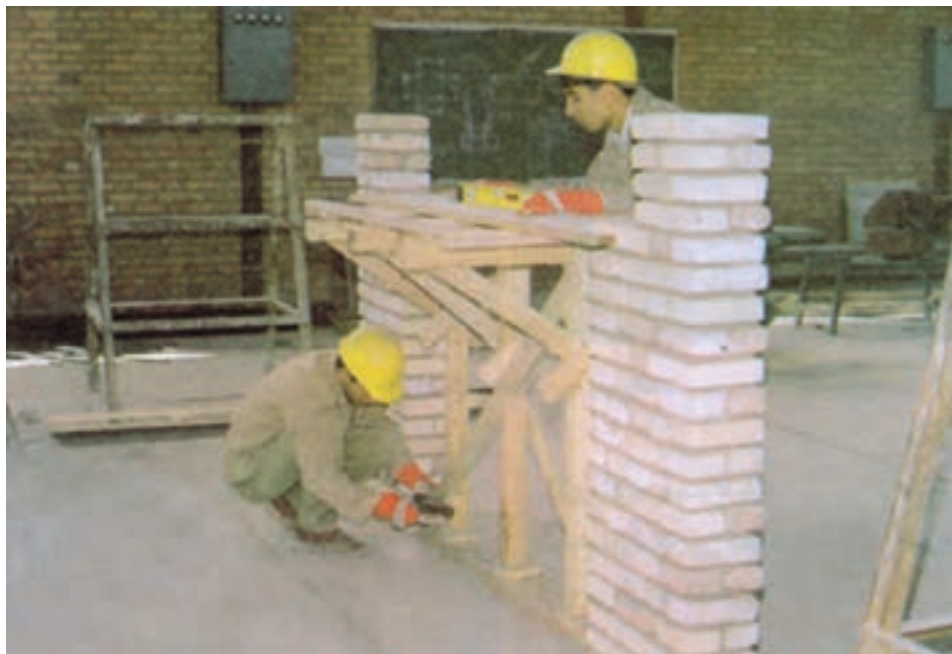
شکل ۳-۶- صفحه‌ی کف قالب نصب شده بر روی شمع‌ها
