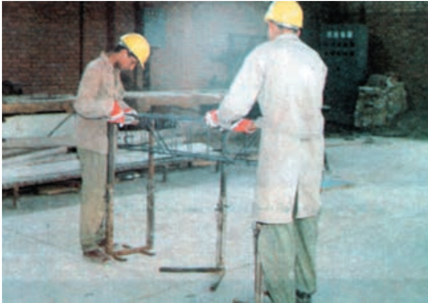
شکل ۱۲-۳- طریقه‌ی مونتاژ آرماتورهای یک پوتر کوچک
