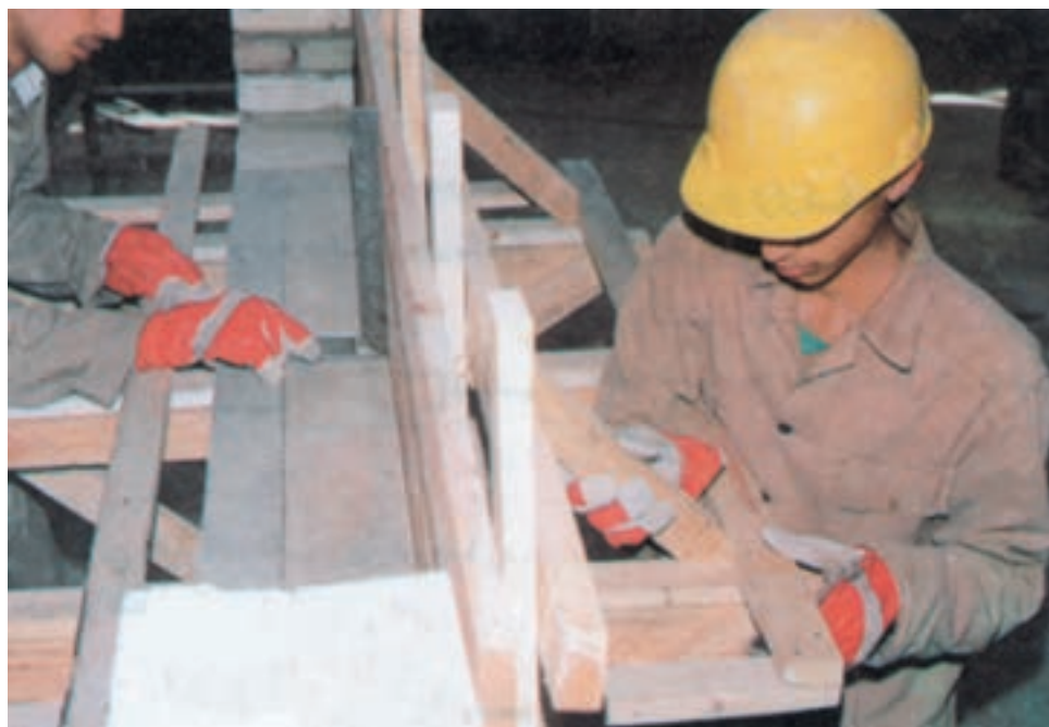
شکل ۱۱-۳- نصب گونه، گونیاکردن و نصب دستک‌ها
