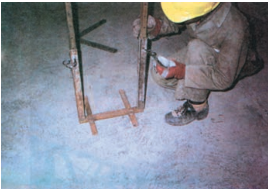
شکل ۲-۹۵- خوک قابل تنظیم برای ارتفاع های متفاوت
