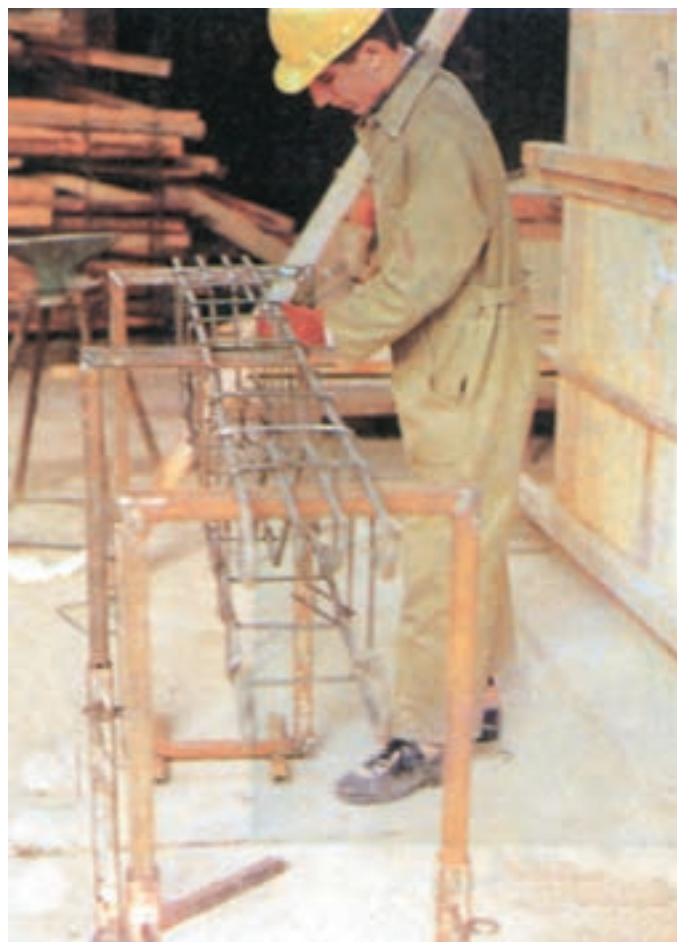
شکل ۹۶-۲- مونتاز میل‌گرد با استفاده از خرک فلزی متحرک
