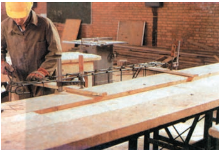
شکل ۹۷-۲- مونتاز میل‌گرد با استفاده از تخته‌هایی که با پیچ‌دستی به میز متصل شده‌اند.
