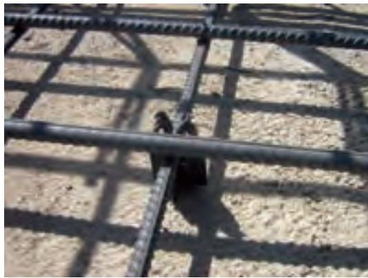
شکل ۱۱-۱۱- استفاده از فاصله انداز (Spacer) مجهت فاصله دادن آرماتورهای کف با بتن مگر
