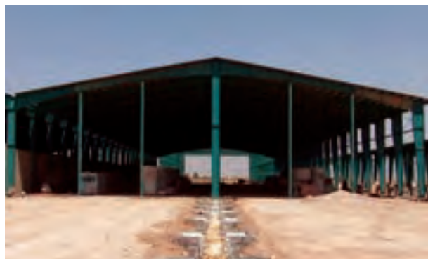
شکل ۲-۵- سازه‌های قابی صنعتی
