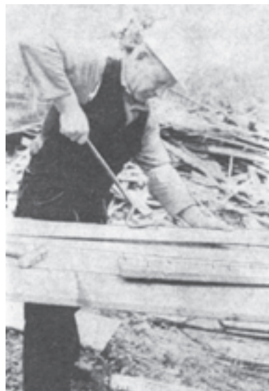
شکل ۳۰-۱ - میخ‌کشی از تخته توسط میخ‌کش اهرمی
