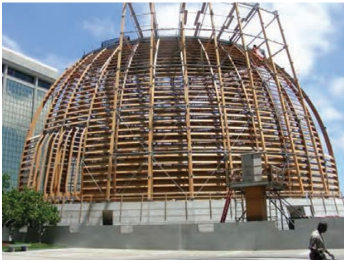
شکل ۴-۲- نمای اسکلت یک گنبد چوبی که سقف یک استادیوم ورزشی را می پوشاند
