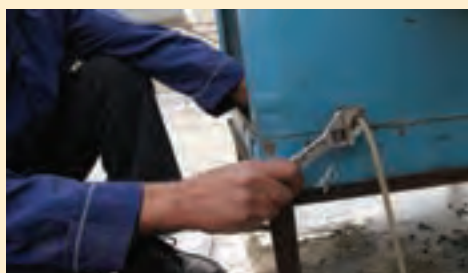
نصب لوله به شیر شناور
