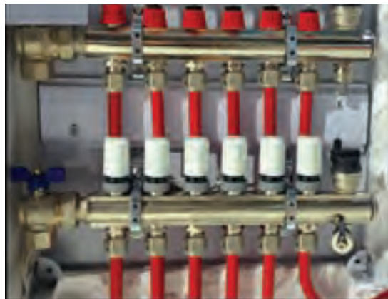
کلکتور سیستم کف گرمایی
