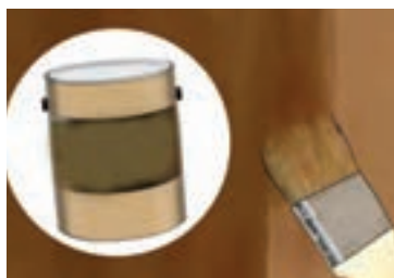
۵- آستر کردن دیوار با آستری (روغن الیف)
