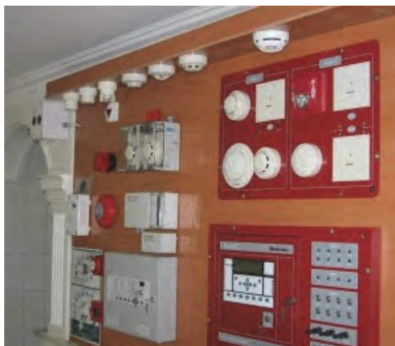
شکل ۹-۴: نمونه‌هایی از سیستم‌های اعلام حریق و کاشفها
