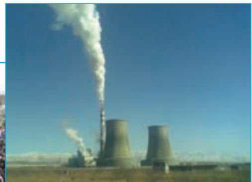
بناب- نیروگاه برق
