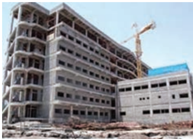
شکل ۱۰-۱۴- عملیات ساخت بیمارستان ۲۰۰ تختخوابی امام رضا(ع)
