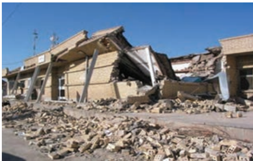
شکل ۱۲-۲- خسارات ناشی از زلزله در استان
