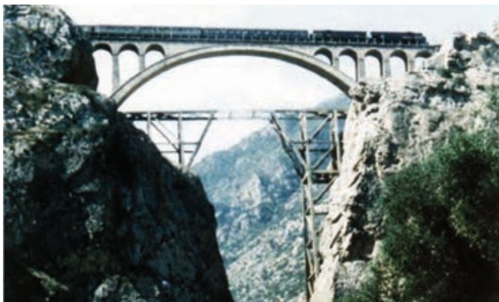
شکل ۲۸-۵- راه آهن شمال - پل ورسک
