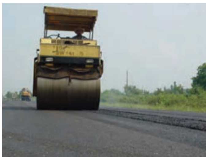
شکل ۴-۶- عملیات راه سازی
