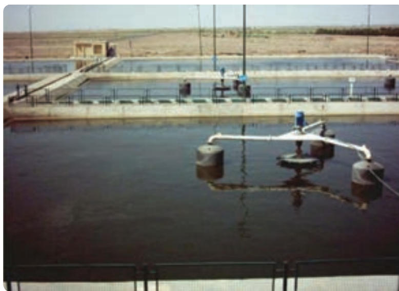
شکل ۴۹-۱. یکی از تصفیه‌خانه‌های فاضلاب شهرک‌های صنعتی استان
