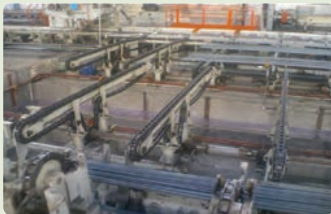
شکل ۲-۶- نمایی از کارخانه فولاد شاهرود
