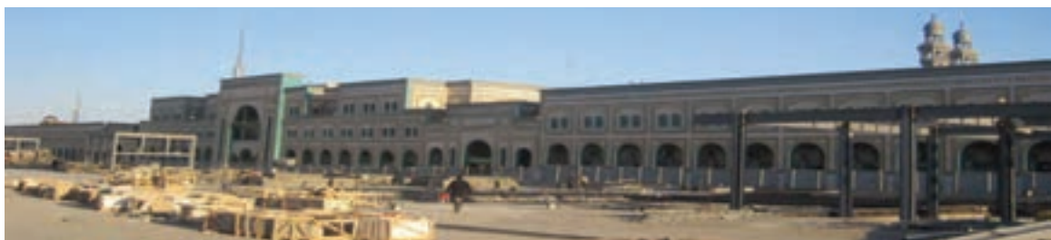
شکل ۱۹-۶- بخشی از میدان بزرگ در حال ساخت امام خمینی (ره)
