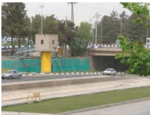
شکل ۱۸-۱- تصویر یکی از چاه‌های آب داخل رودخانه
