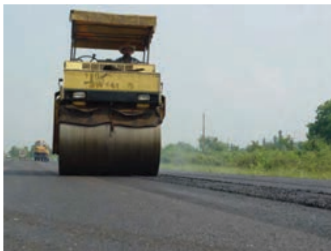
شکل ۴-۶- عملیات راه سازی
