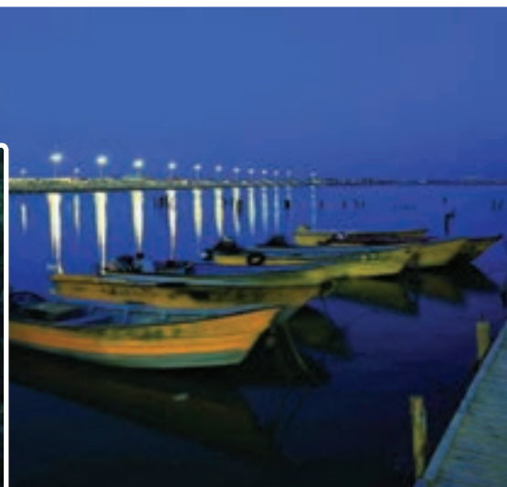
شکل ۳-۵- اسکله بندر ترکمن
