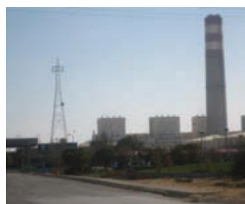
شکل ۱۹-۵- نیروگاه برق شهید مفتاح - فامنین
