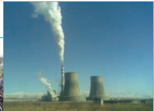
بناب- نیروگاه برق
