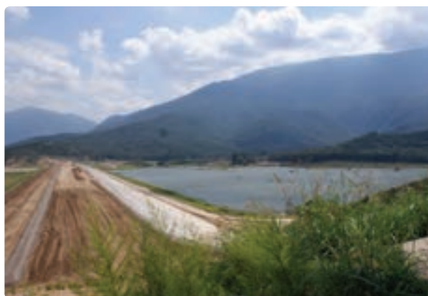
شکل ۴۰-۱- سد زرین گل در جنوب شهر علی آباد
