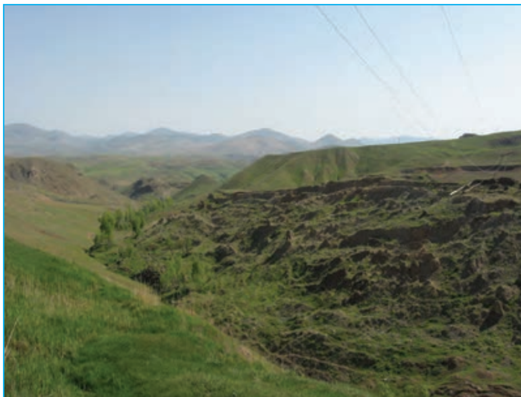
شکل ۱۵-۱- لغزش زمین در نصیرآباد و رزقان
