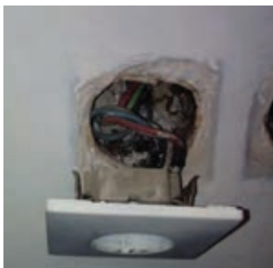
شکل ۵-۳- قاب جداشده پریز از دیوار
