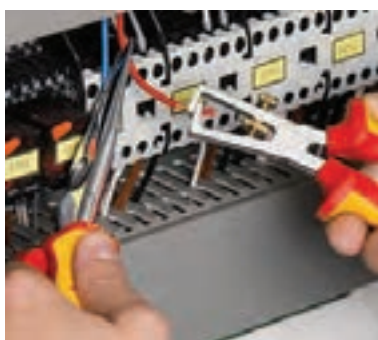
شکل ۱-۹- روکش برداری با سیم لخت‌کن دستی
