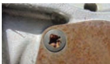
(ب) استفاده ناصحیح از آچار پیچ گوشتی
