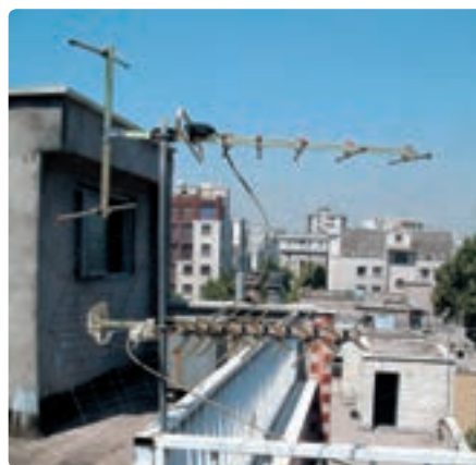
شکل ۱۸-۴ آنتن VHF و UHF روی دکل
