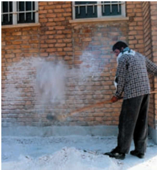
گردپاشی خارج از جایگاه
