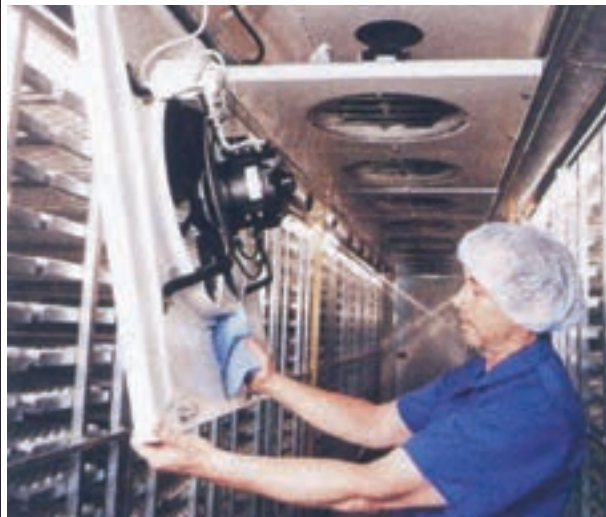
تصویر ۲۱-۴- سرویس دستگاه‌های تهویه
