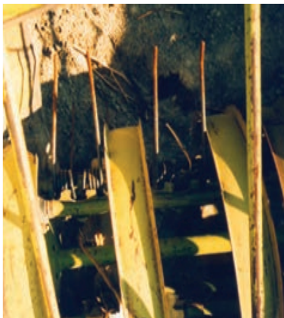
شکل ۱-۲۱- پایه انگشتی شکسته
