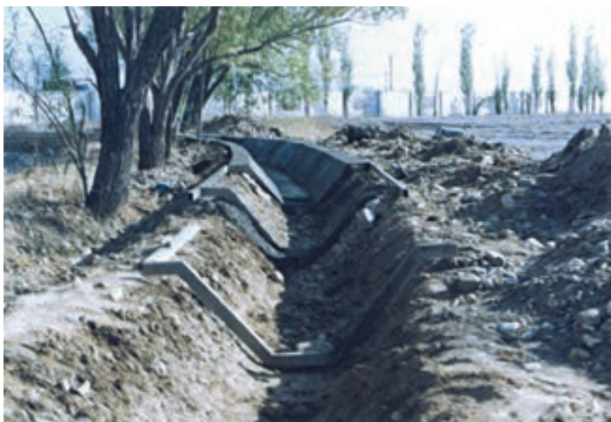
شکل ۱۰-۵- پوشش انهار، تلفات آب را در مسیر انتقال به حداقل می رساند.
