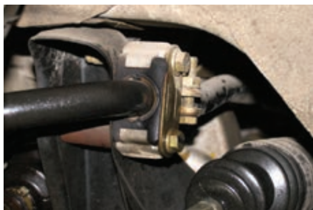
شکل ۱۳۲-۳- نصب بست‌های میل موج گیر بلند
