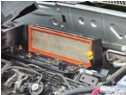
شکل (۲-۶۲) فیلتر سیستم هوارسانی
