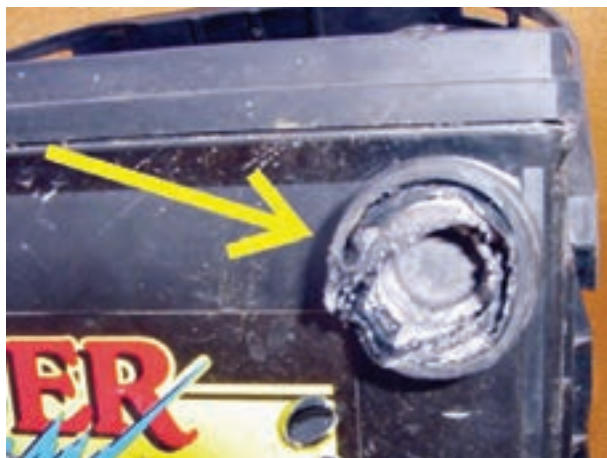
شکل ۳۶-۲- معیوب بودن ترمینال باتری
