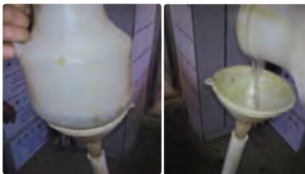
شکل ۱۸-۵- شست‌وشوی مبدل بعد از رسوب‌زدایی
