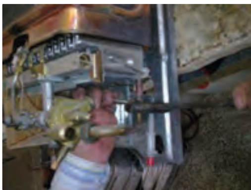
شکل ۸-۱- مبدل گرمایی
