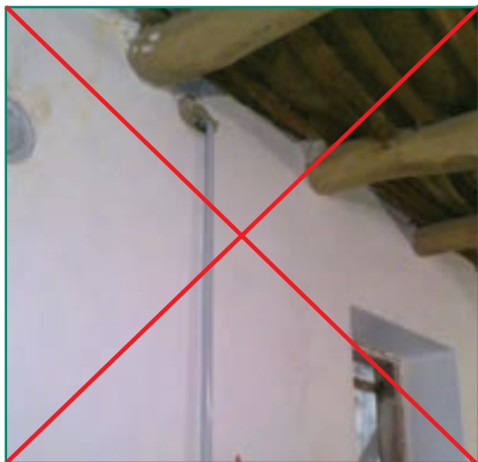
شکل ۴-۷ الف سقف نباید چوبی باشد
