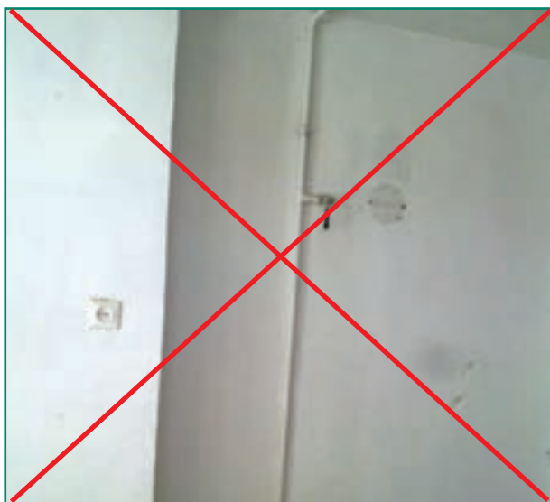
شکل ۴-۷ ب. فاصله شیر روشنایی از سقف کمتر از ۸۰ سانتی متر نباشد.
