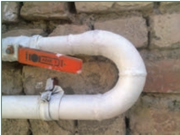
شکل ۸۲-۴ ب بعد از کنتور لوله از \frac{1}{4} به ۱ تبدیل شده است
