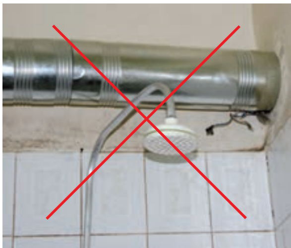
شکل ۳-۱۱ عبور غیر مجاز دودکش
