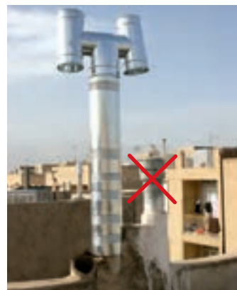
شکل ۴۰- ۱ دهانه خروجی دودکش بر روی بام با کلاهک H
