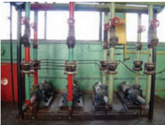
شکل ۵-۳- کاربرد لوله درزدار در لوله‌کشی شوفاز
