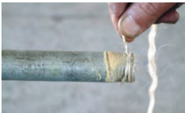
شکل ۵-۵۴- پیچیدن کنف بر روی سردنده
