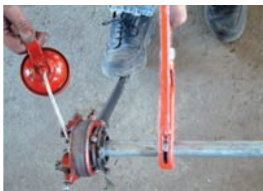
شکل ۱۲۱-۵- استفاده از روغن در جریان حدیده کاری
