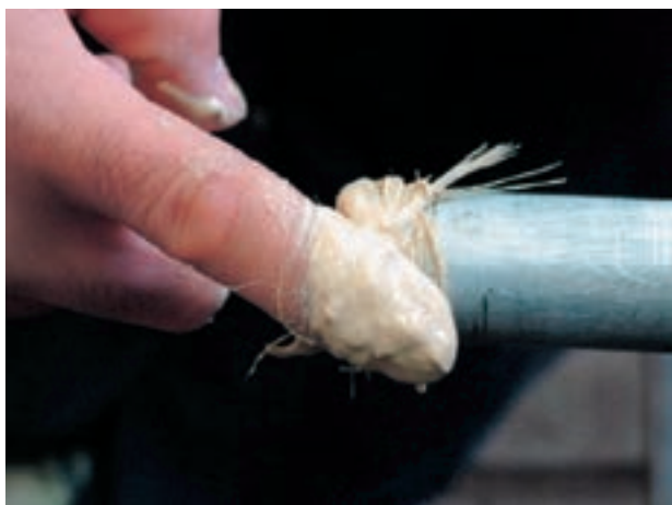
شکل ۵-۹۰- خمیر و کنف کردن سردنده
