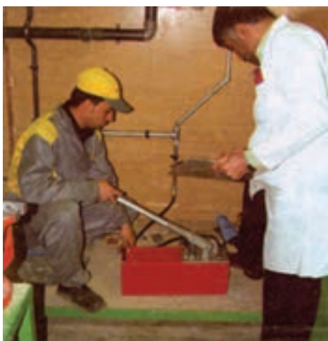
شکل ۵-۹۳- نحوه‌ی آزمایش با پمپ آزمایش دستی
