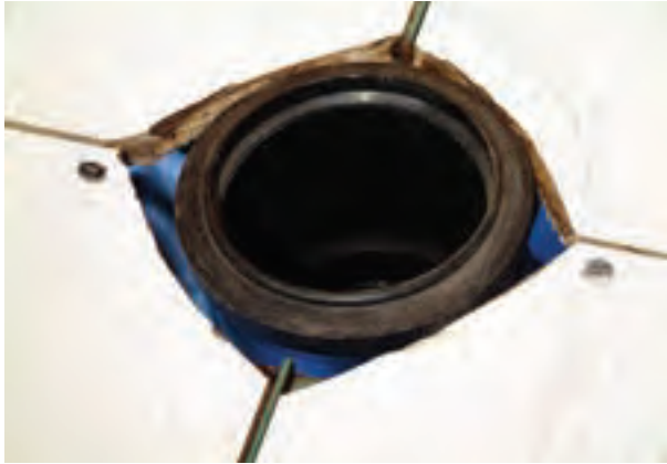
شکل ۲۴۴-۳- قرار دادن بوگیر در داخل زانویی
