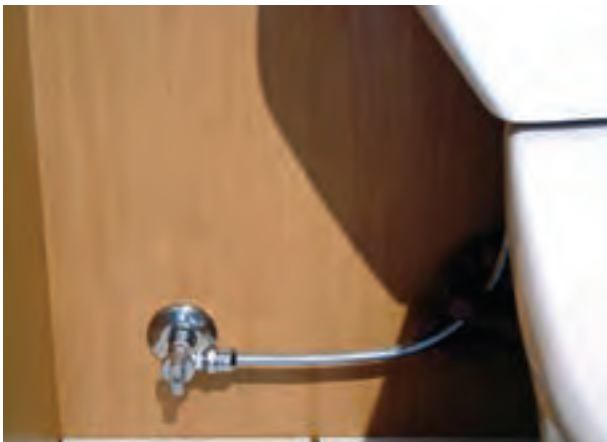
شکل ۲۵۷-۳- اتصال لوله‌ی پیسوار و باز کردن شیر پیسوار
