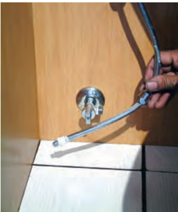
شکل ۳-۲۵۵- خمکاری لوله‌ی پیسوار
