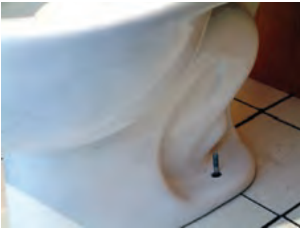
شکل ۳-۲۴۸- قرار دادن توالت فرنگی در محل خود
