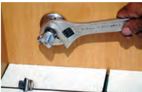
شکل ۳-۲۵۴- سفت کردن شیر پیسوار
