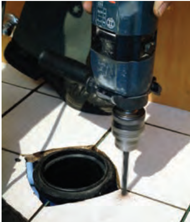
شکل ۲۴۶-۳- سوراخ‌کاری محل‌های علامت‌گذاری شده
