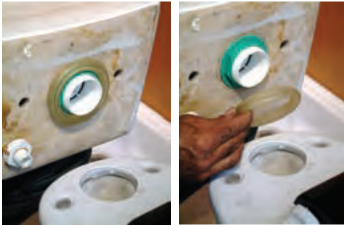
الف - قبل از قرار دادن لاستیک رابط بر روی مهره‌ی اتصال پمپ تخلیه ب - بعد از قرار دادن لاستیک رابط بر روی مهره‌ی اتصال پمپ تخلیه
