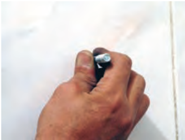
شکل ۳-۴۳- بستن پیچ‌ها در درون رولپلاک‌ها با دست
