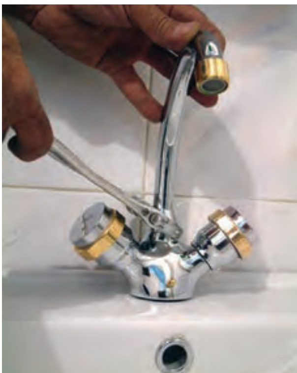
شکل ۳-۵۱- سفت کردن مهره‌ی عَلم شیر با آچار فرانسه
