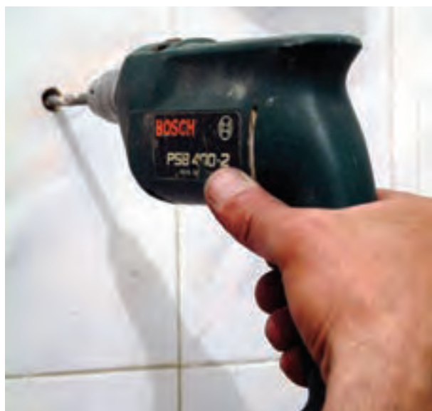
شکل ۳-۴۱ سوراخ کاری محل نصب پیچها
