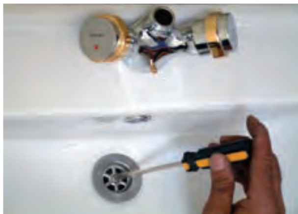
شکل ۳-۴۰ نصب زیراب بر روی دستشویی
