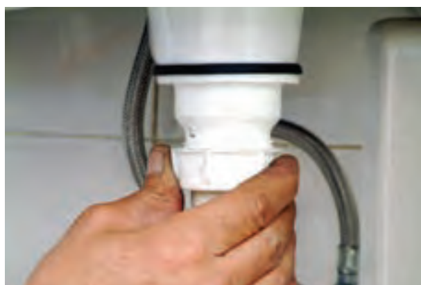
شکل ۳-۵۶- بستن مهره‌ی لوله‌ی عمودی سیفون به زیراب
