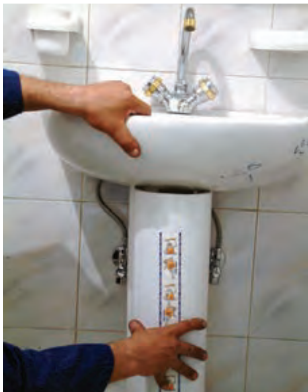
شکل ۳-۵۸- قرار دادن پایه‌ی دست‌شویی در زیر آن
