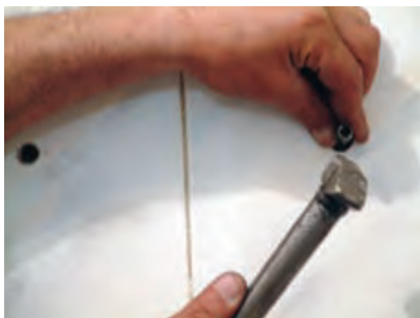
شکل ۳-۴۲ کوبیدن رولپلاکها در درون سوراخها
