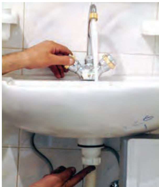
شکل ۳-۵۷- عمل کنترل نشت آب از محل‌های اتصال
