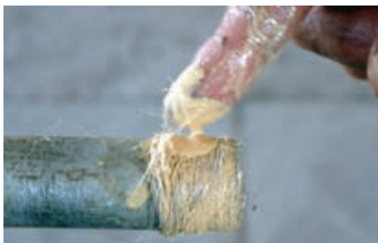
شکل ۱۵۲-۵- خمیر و کنف کردن سردنده‌ها
