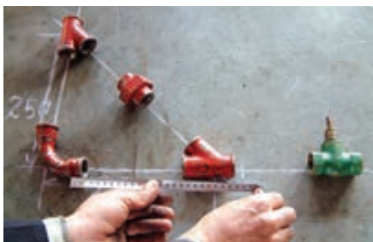
شکل ۱۳۴-۵- اندازه‌گیری لوله‌های مورد نیاز
