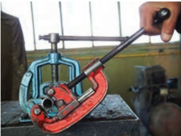
شکل ۱۵۰-۵- بریدن لوله ها
