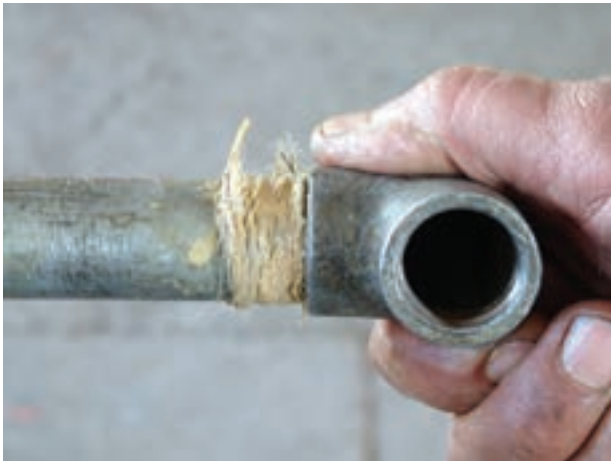
شکل ۵-۹۱ بستن فیتینگ بر روی سردنده
