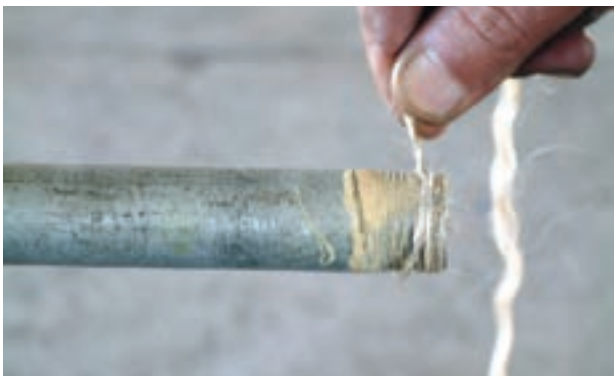
شکل ۵-۵۴- پیچیدن کنف بر روی سردنده
