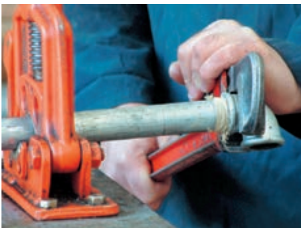
شکل ۵-۹۲ سفت کردن فیتینگ به وسیله‌ی آچار لوله‌گیر
