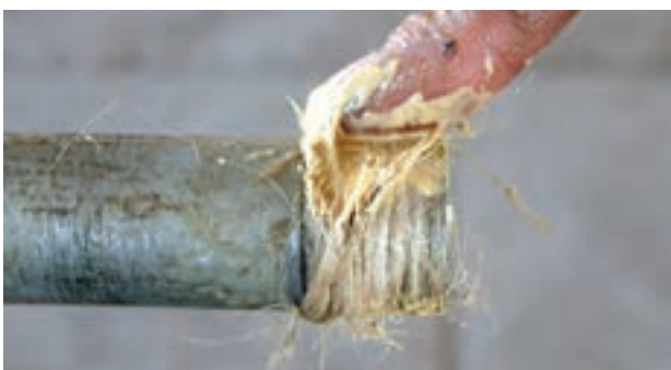
شکل ۵-۵۷- مالیدن خمیر آب بندی بر روی کنف
