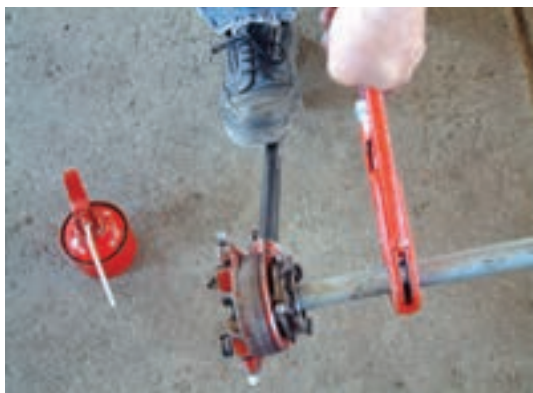
شکل ۱۲۰-۵- عمل حدیده کاری لوله
