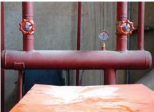
شکل ۳۲-۵- استفاده از اتصال جوشی در حرارت مرکزی
