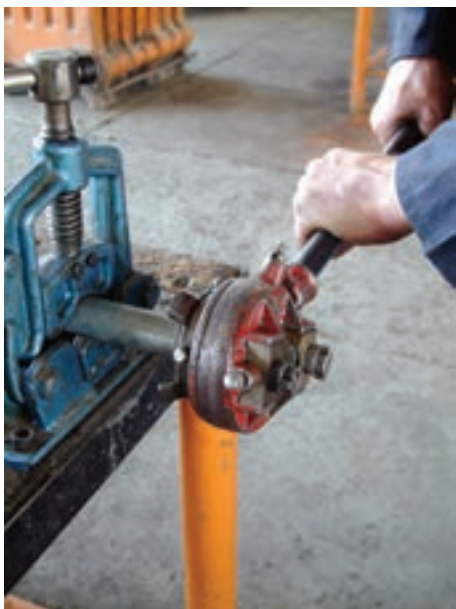
شکل ۳۴-۴- حدیده کردن لوله
