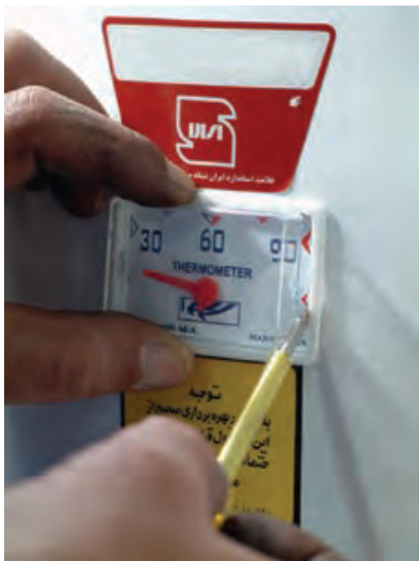
شکل ۱۱۶-۱- جدا کردن ترمومتر
