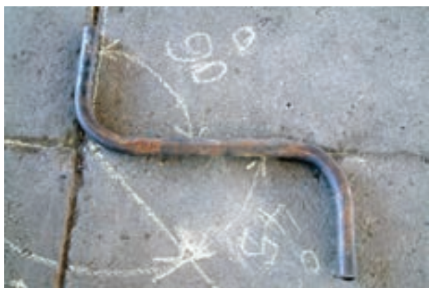
شکل ۳-۴۱- عدم دویدگی لوله‌ی دو خم
