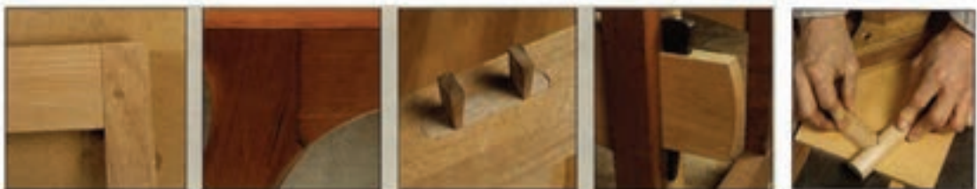
اتصال میانی آلت چینی اتصال گوه ای اتصال میانی با گوه فاق و زبانه با دویل شکل (۳-۵) موارد ۱ تا ۵
