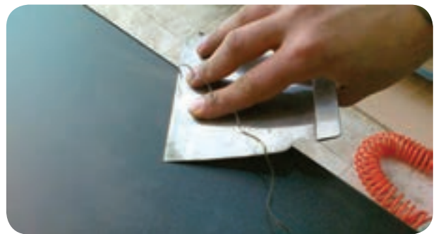
شکل ۲۵-۴ - نحوه برطرف کردن اضافه نوار با لیسسه
