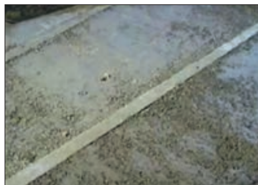
شکل ۲۱-۶ پرکردن فضای بین کرم‌ها با پوکه معدنی
