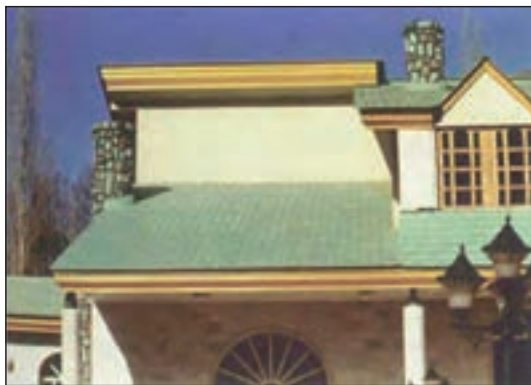
شکل ۱-۱۰۲ پوشش سقف با ورق‌های فشرده‌ی آردواز
