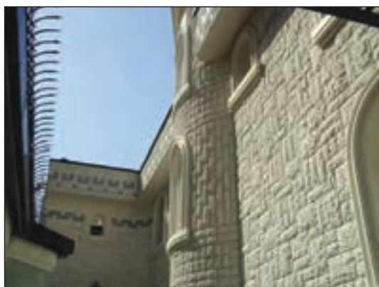
شکل ۱۳۱-۱ دیوار با مصالح سنگ بادبُر
