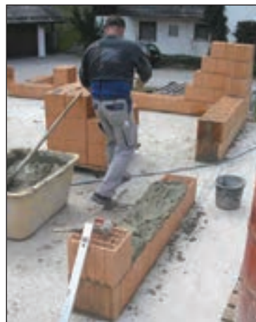
شکل ۱-۱۵۳ ساخت دیوار با بلوک سفالی
