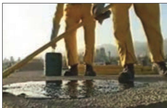
شکل ۲۲-۶ قیرگونی پس از پرکردن بین کُرم‌ها
