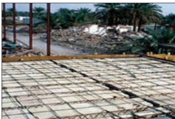
شکل ۱۳-۱ سقف تیرچه بلوک
