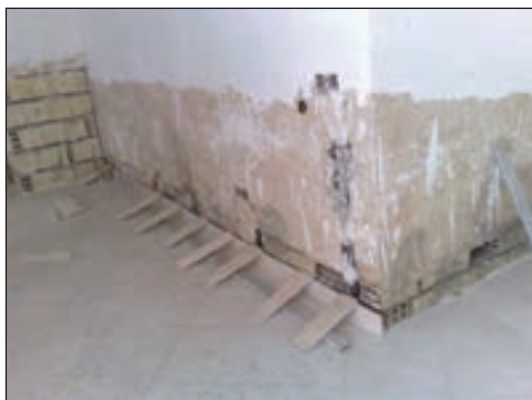
شکل ۱-۹۰ اندود گچ و خاک - گچ سفید پرداختی
