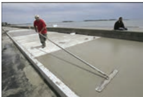
❖ شکل ۳-۵۵ رویه نهایی معابر با بتن درجا
